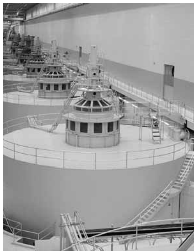
Aplicación de bombeo
