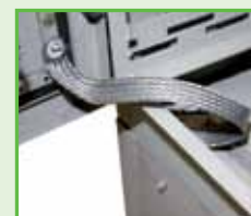
Conexión a tierra y equipotencial
